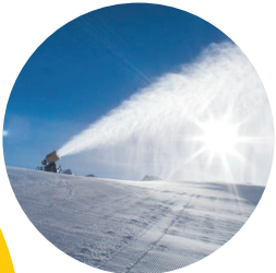
Impianto di innevamento
